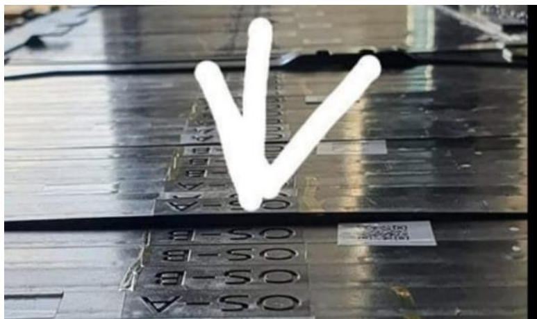
Sele 24. Hyundai Kona kõrgepingeaku paisunud element [32]
